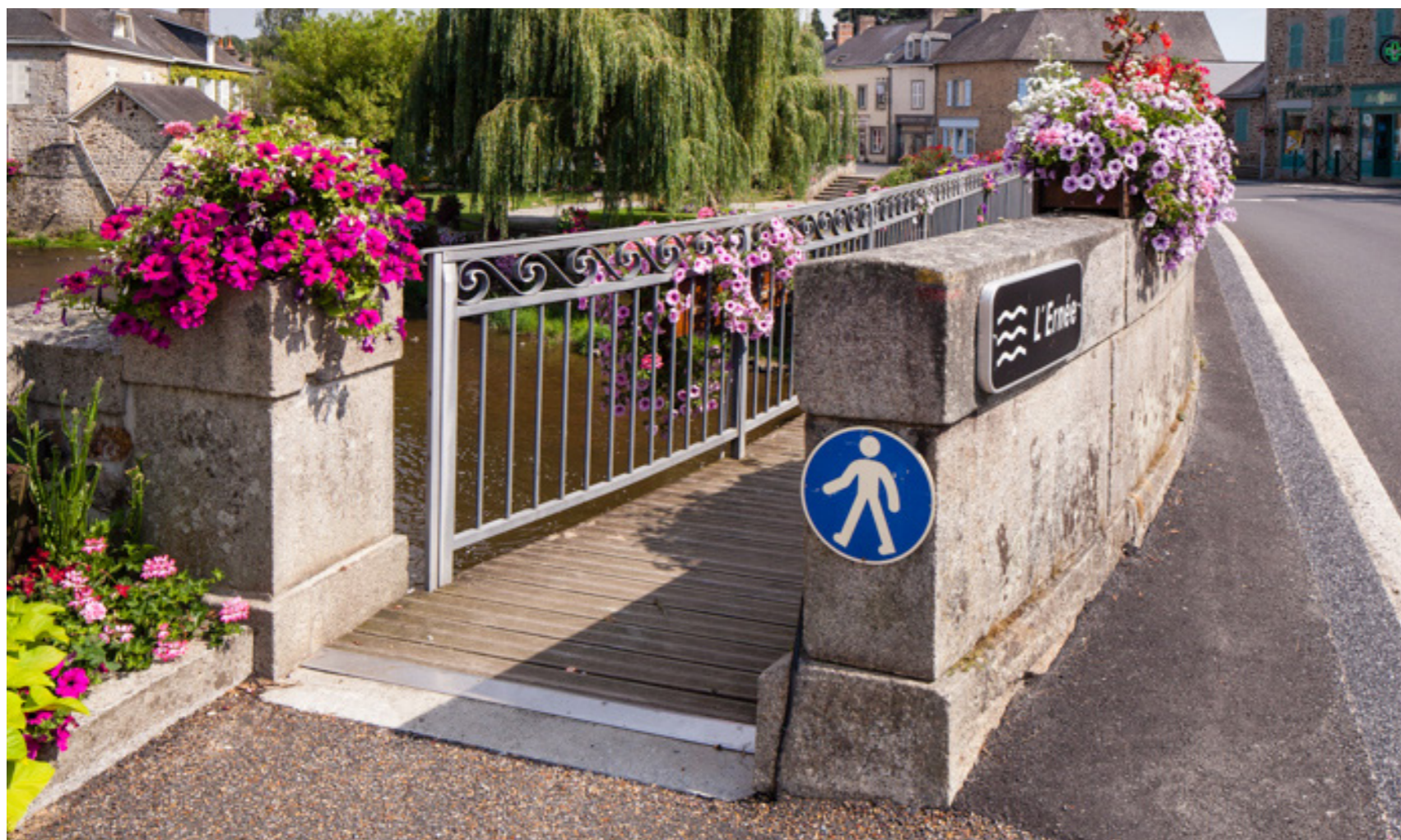
Doublement du tablier de pont par une passerelle piétonne ajourée
